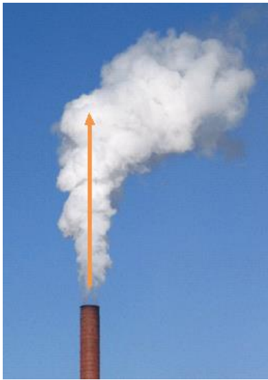
Figuur 13: Indicatie van de pluimstijging, aangegeven met de pijl. De emissie vindt plaats ter hoogte van de bovenkant van de schoorsteen. De emissie stijgt echter op ten gevolge van de pluimstijging. De effectieve uitreedhoogte ligt hierdoor ter hoogte van de bovenkant van de pijl.
